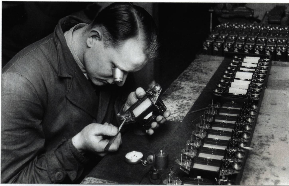
Ein Blick in die Exakta-Produktion der 30er Jahre. Hier ist der Mechaniker beim Justieren des Langzeitenwerkes der Exakta B zu sehen.
