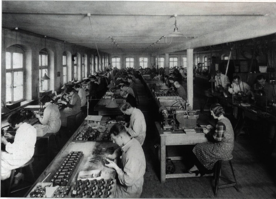
Frauen und Männer bei der Arbeit im Montagesaal der Ihagee in Dresden. An unterschiedlichen Tischen werden verschiedene Arbeiten ausgeführt, z.B. das Einsetzen des Objektivtubus.
