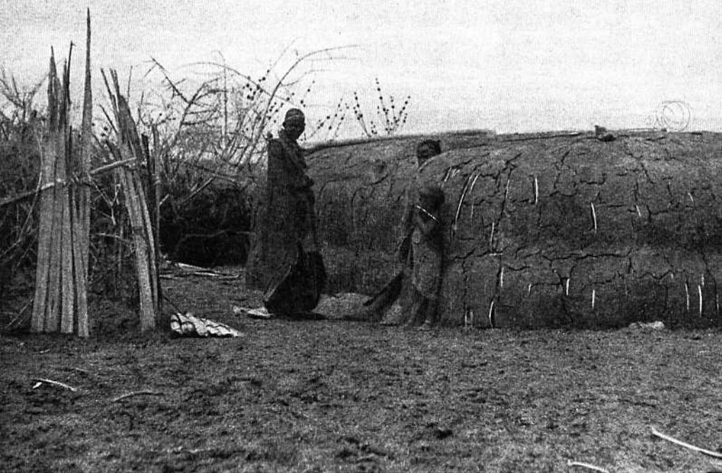
Aus Ästen, Kuhmist und Lehm bauen die eigentlichen Herren der Steppe, die Masai, ihre Hütten in der Nähe von Wasserstellen.
