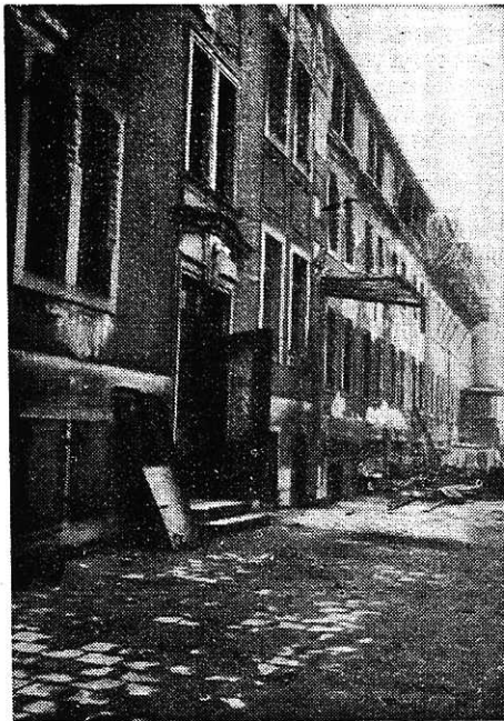
Ausgebrannte Produktionsräume der Ihagee-Kamerawerke
