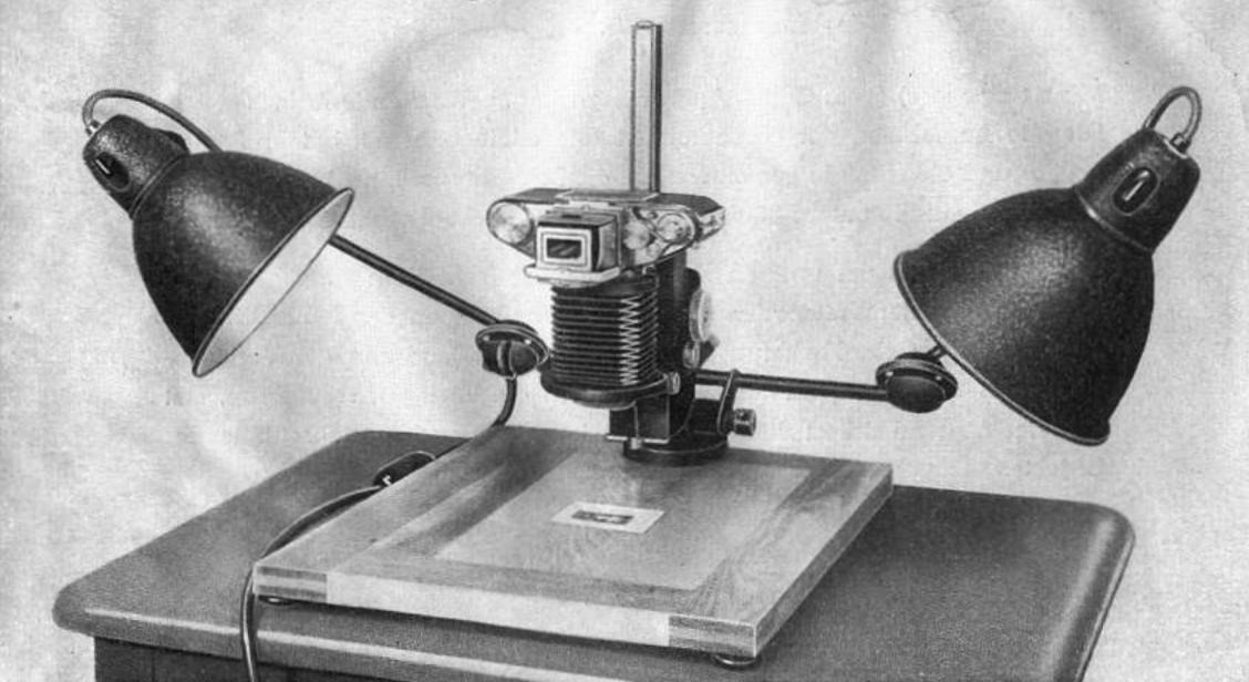
Zweck: In Verbindung mit den Reprogeräten 1 und 2 gleichmäßige Ausleuchtung aller Reproduktionsvorlagen oder bei anderen Nahaufnahmen Beleuchtung des Aufnahmegegenstandes.
